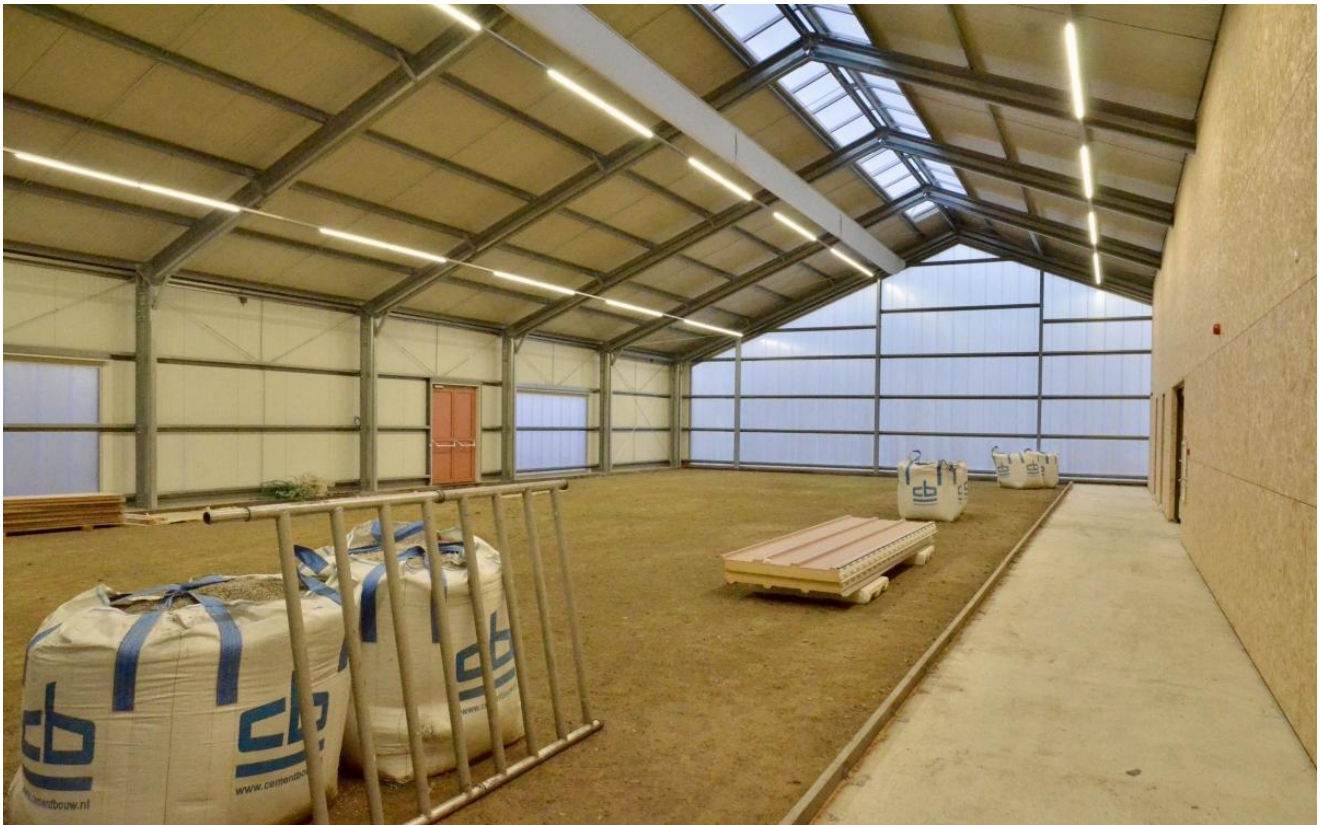
Overzichtsfoto van het interieur van onze speelhal. De LED-verlichting is aangebracht en op het pad rechts zijn inmiddels tegels gelegd. Rest nog de toplaag grind aan te brengen. Foto is van 24 januari 2024 en afkomstig van de website Hillegom Online.
